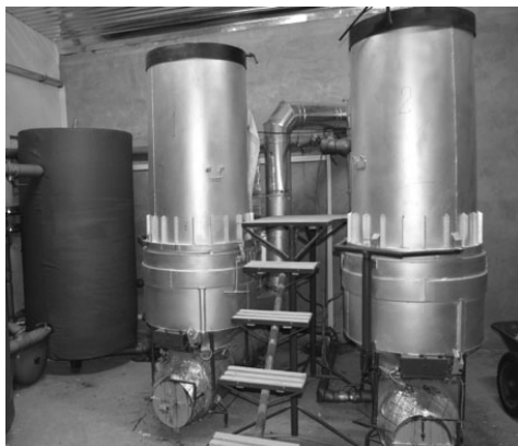
Фото 1. Утилізаторна газогенераторна піч з водяним теплообмінником моделі СУП-ВТ 80М
